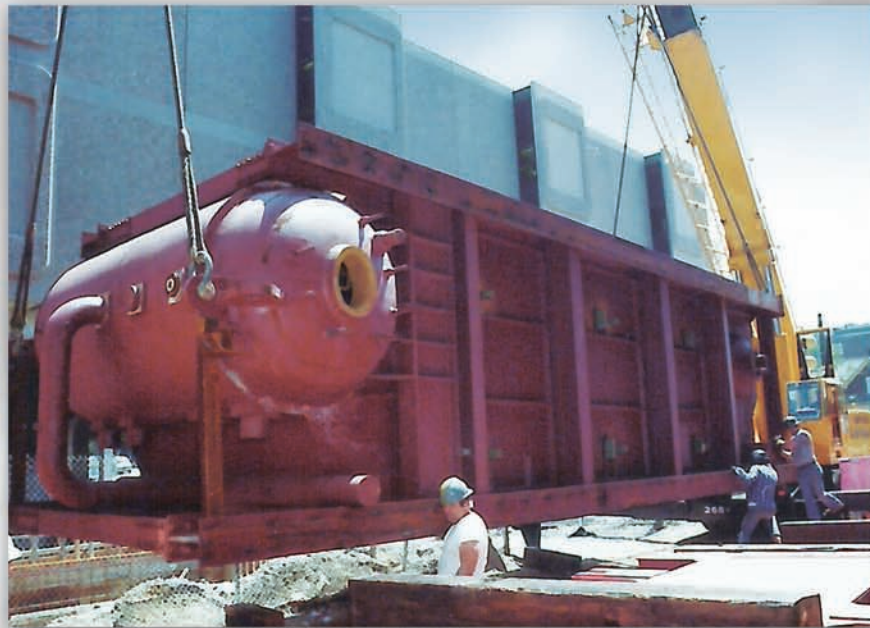
HRSG fully assembled modular box replacement
